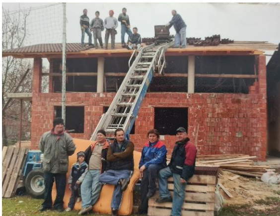
Slika 3: Gradnja prostorov za NK Cankova ob igrišču (Vir: osebni arhiv D. Kacijan, 2023)
